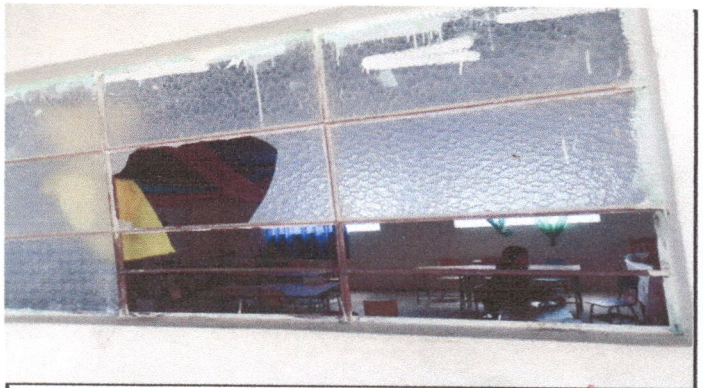
Foto 4: sustitucion de ventanas mas vidrios
