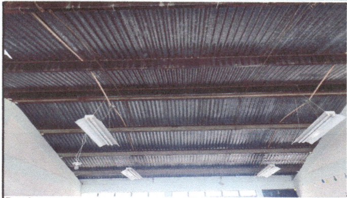
Foto 1: Sustitucion de lamparas Tripold
