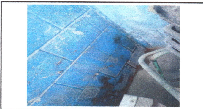
Foto 5: repello en muro
